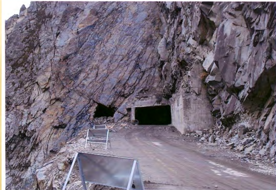
馬陵3號隧道震災施工後
