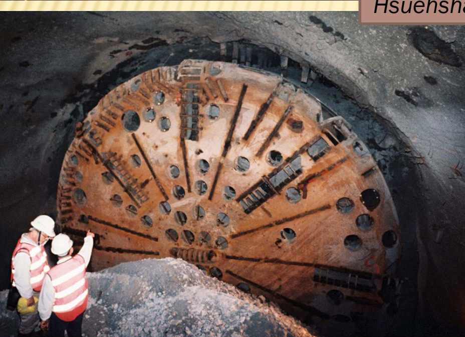
雪山隧道主坑鑽機(TBM)洞內維修中
