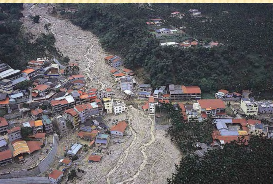
新中橫公路水里玉山線沿陳有蘭溪開通之後，平地人進入開墾，部分房屋濫建於野溪之谷中與谷口，受到土石流災害（連永旺攝）
